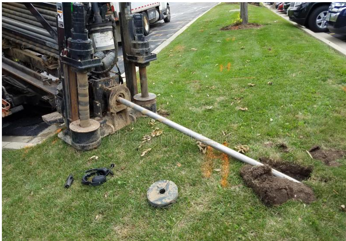
Photo : Insertion de la tige dans le sol à partir de la machine de forage.
