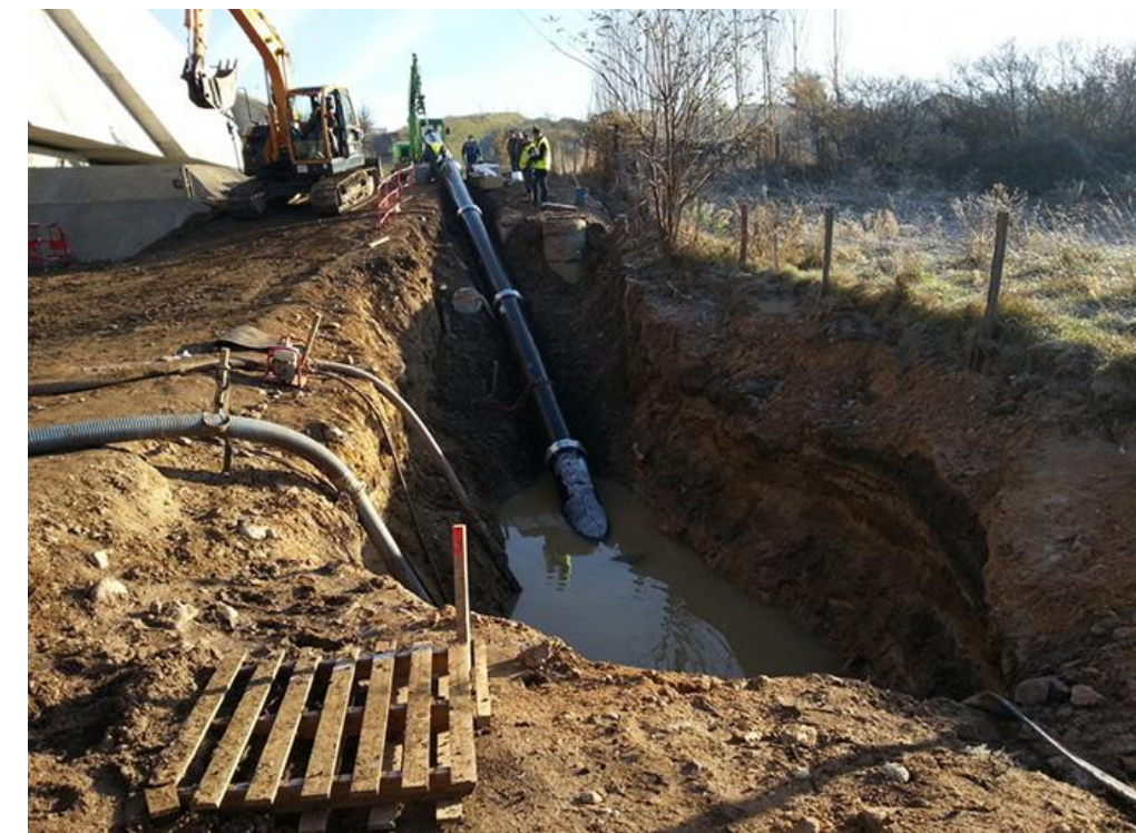
Photographie : Exemple de point de départ avec canalisation engagée
