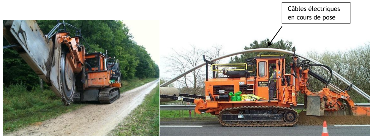
Photographies : Trancheuse à l'arrêt et en action
